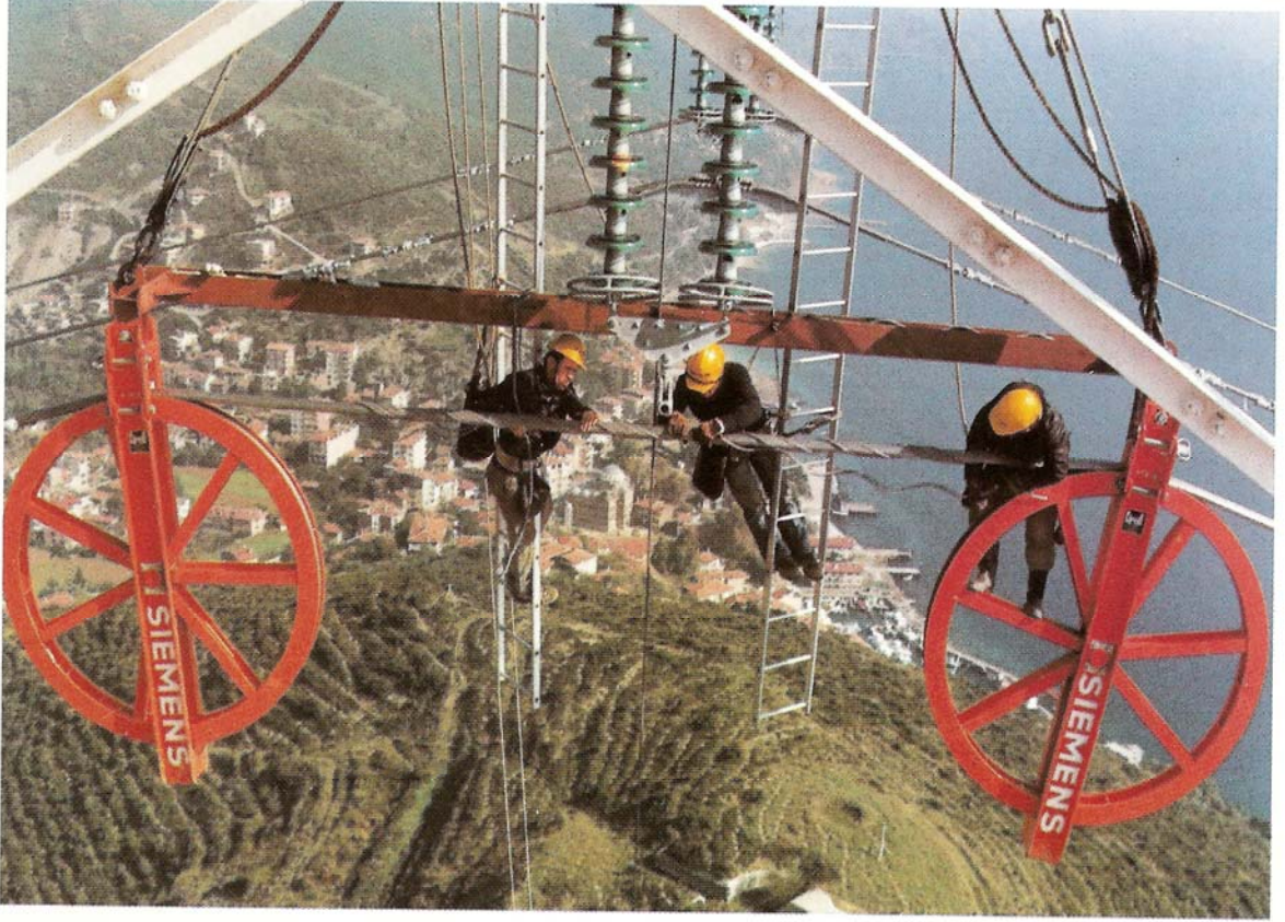
Tel çekim çalışmaları ( iletkenin makaralardan klempe aktarılması )
