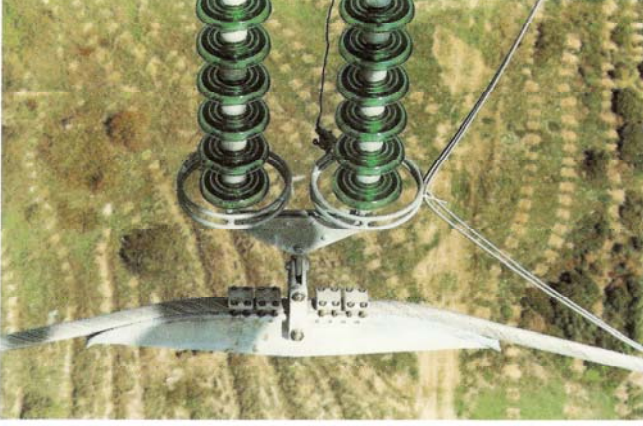
Eyer tipi askı klemp tesisi
