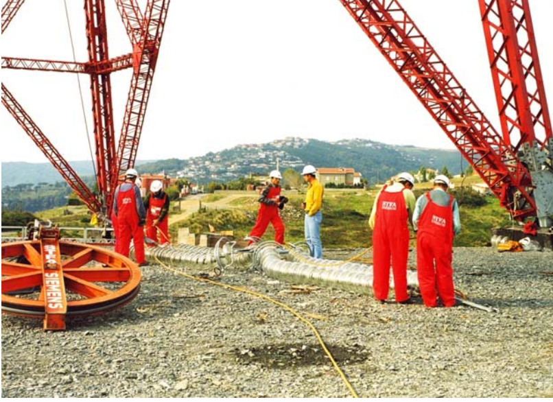
Resim 3 : Çift V askı zincir izolatör takımının yerde montajı
