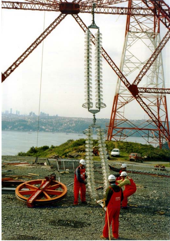
Resim 4 : Çift V askı zincir izolatör takımının montaja hazırlanması
