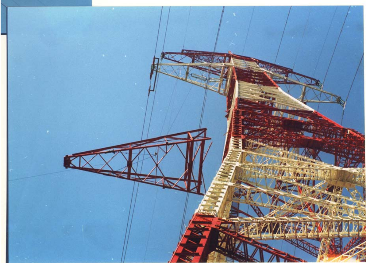
Resim 6 : Taşıyıcı atlama direğinde konsol montajı
