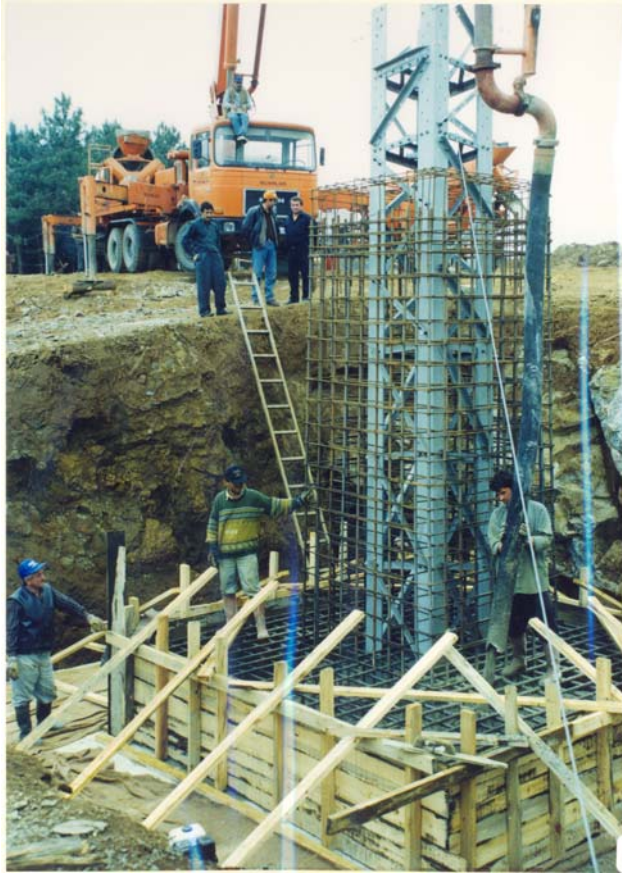
Resim 1 : Taşıyıcı atlama direklerinin (tip BS) temel montajından görünüm
