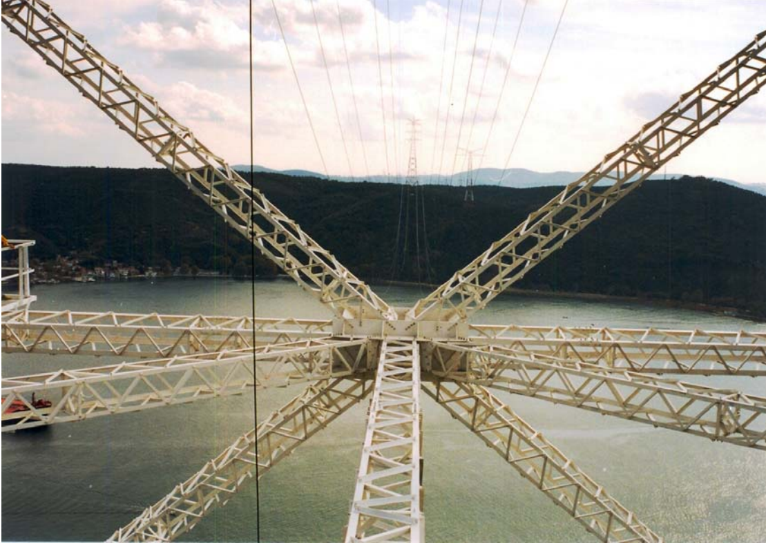
Resim 5 : Taşıyıcı atlama direğinde dört köşebentten oluşan örgülü kafesler
